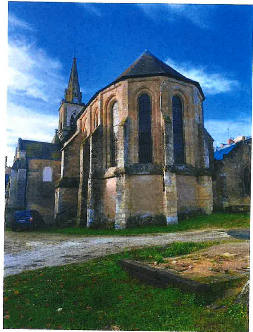
Façade Est – Chevet gothique
