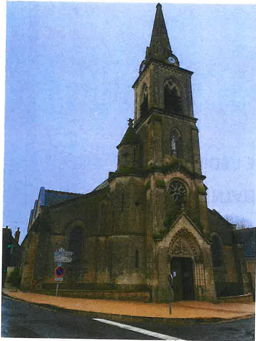
Façade Ouest – Massif de clocher
