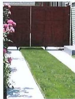
Stationnements en dalle béton avec engazonnement central
